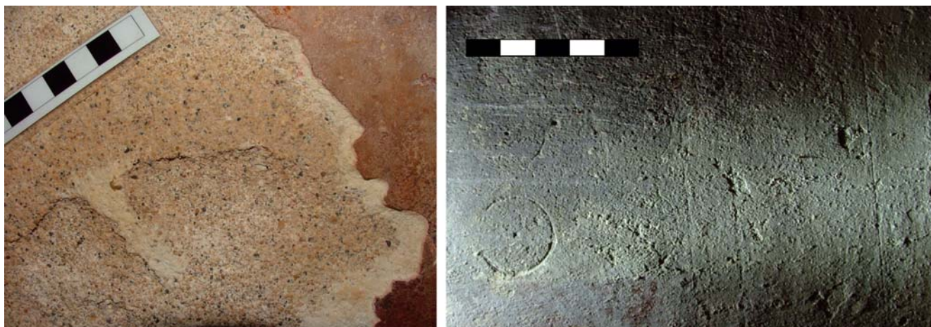
Abb. 12: Cirene, Tomba dell'architettura illusionistica/S64, (a) strati di supporto alle pitture e (b) disegni preparatori ad incisione
